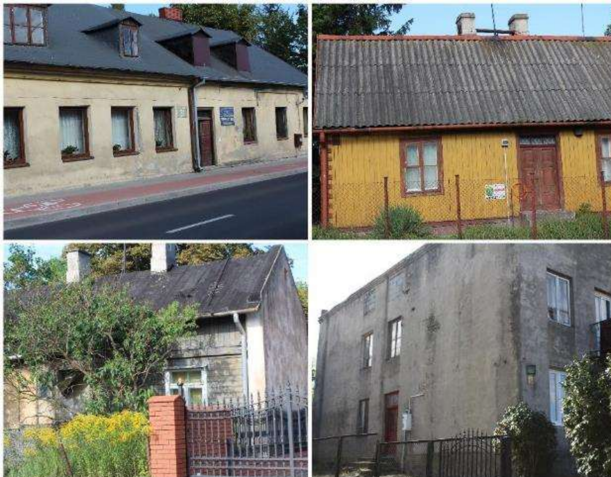
Fot. 5. Przykłady problemów technicznych w mieszkalnictwie na obszarze rewitalizacji A.
