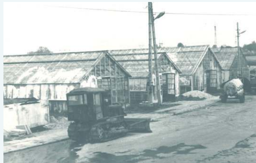
Lata siedemdziesiąte ubiegłego wieku. Nieistniejące już szklarnie Przedsiębiorstwa Gospodarki Komunalnej i Mieszkaniowej na terenie dzisiejszej bazy Zakładu Gospodarki Komunalnej w Trojanowie Źródło: Archiwum Ryszarda Nowakowskiego
